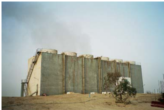
"Chott El Fejj" cooling tower
