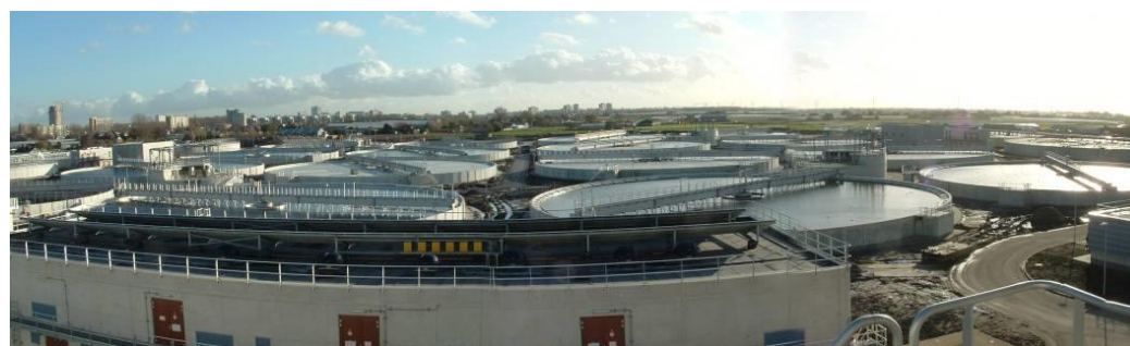
Michiel DvT opent afsluiter en laat allereerste afvalwater in RWZI Harnaschpolder binnen.
